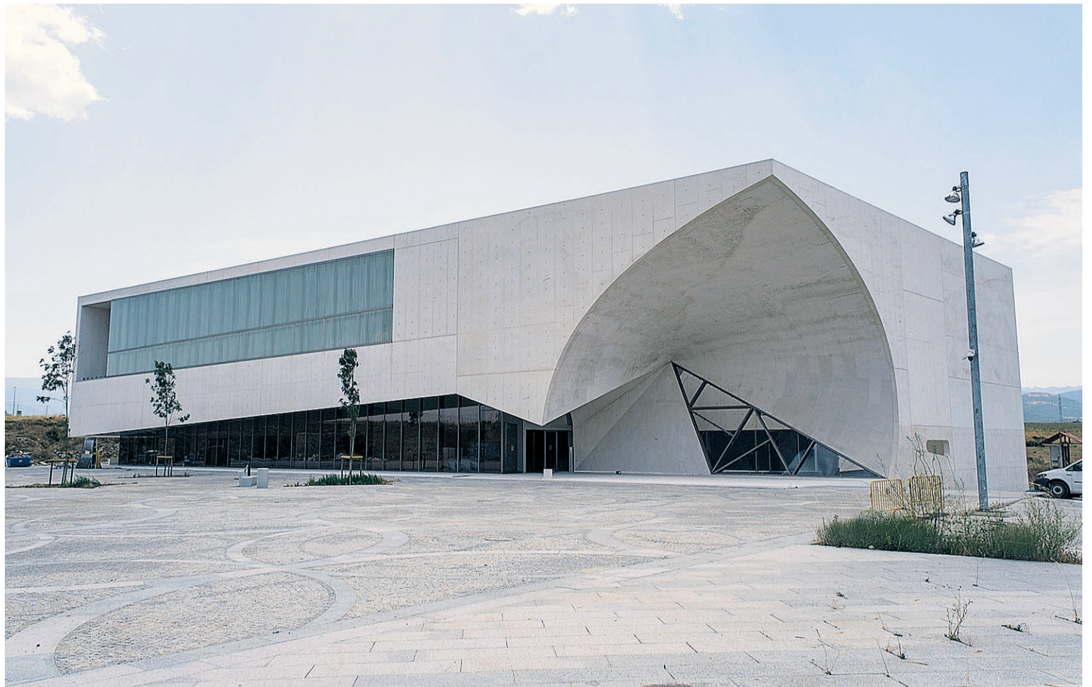
Las primeras obras del Centro de Innovación y Desarrollo Empresarial (CIDE) comenzaron en mayo de 2011. Fachada principal del edificio.
