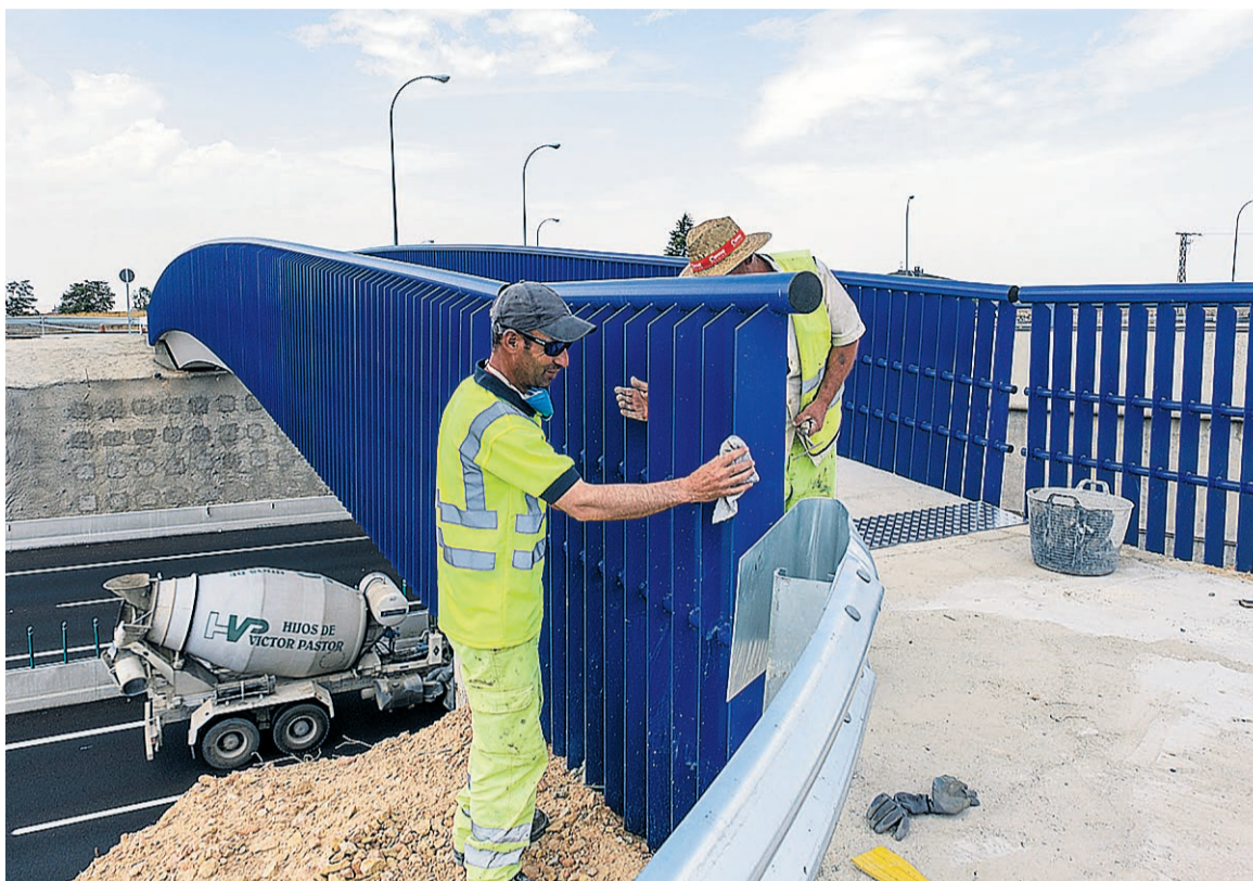
Dos operarios trabajan en las obras de la carretera de circunvalación SG-20.
