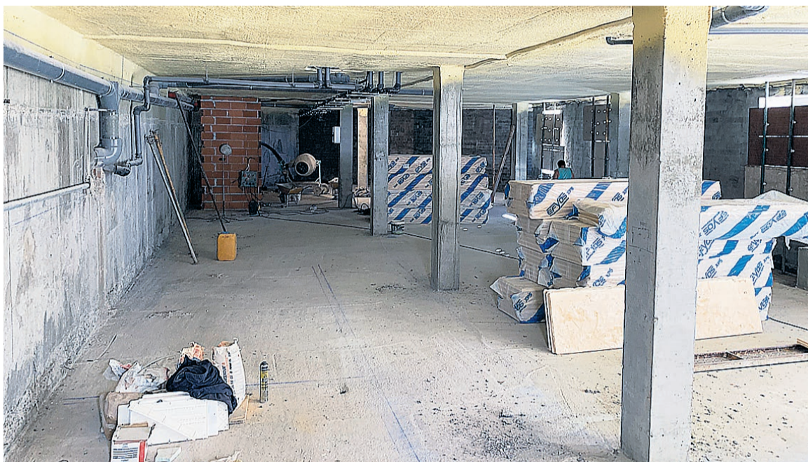
Trabajos en el local sobre el que ya se está trabajando, en los bajos del edificio de Niñas Huérfanas.
