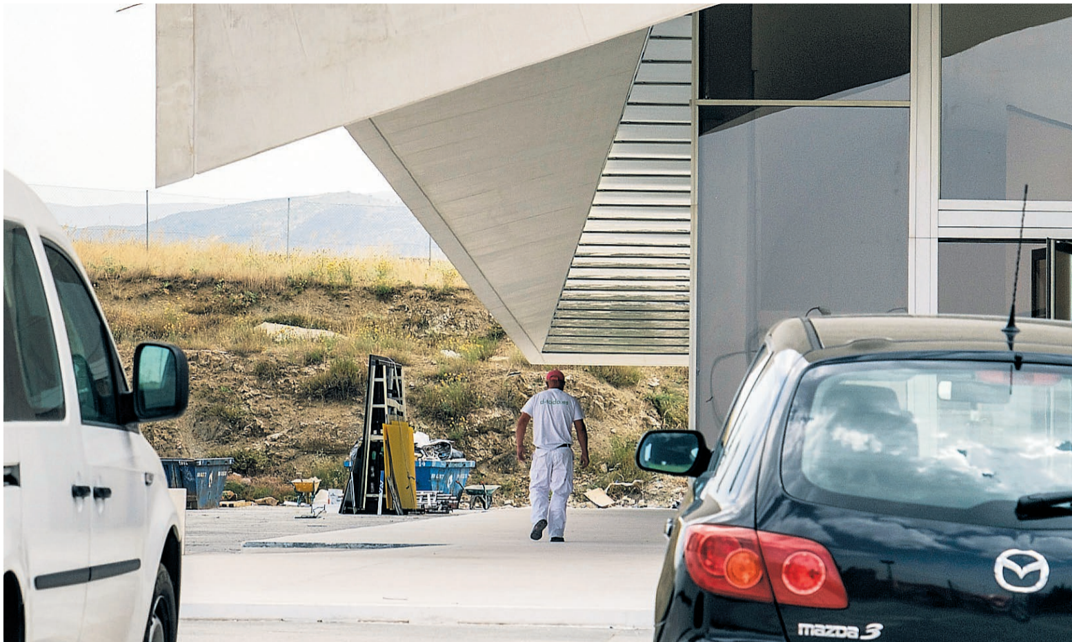
La actividad era visible todavía ayer martes en las instalaciones de este inmueble municipal.
