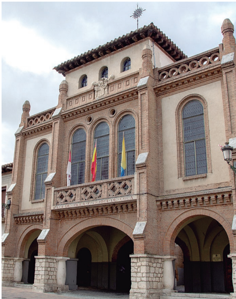
Fachada del Ayuntamiento de Coca.
