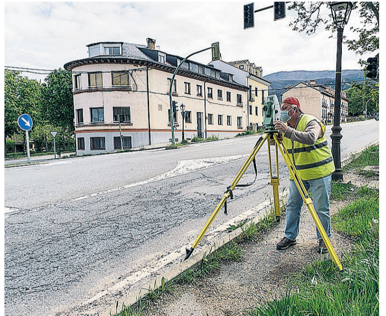
Un operario, analizando la vía en la que se va a intervenir.
