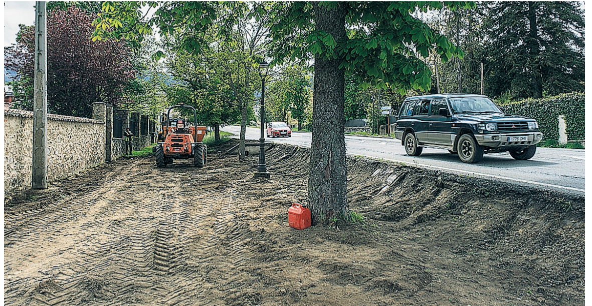
Ya se han iniciado los trabajos de limpieza de las cunetas en la entrada a La Granja.
