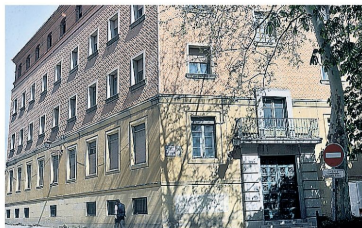
Fachada del Hospital Policlínico que lleva años cerrado.
