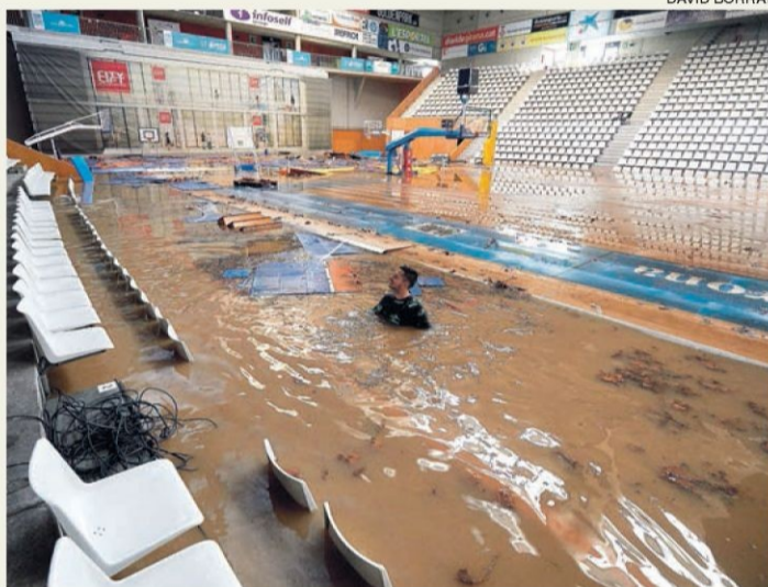
El Pabellón Municipal de Fontajau de Girona quedó inundado a causa del desbordamiento del río Ter, próximo a las instalaciones deportivas.
