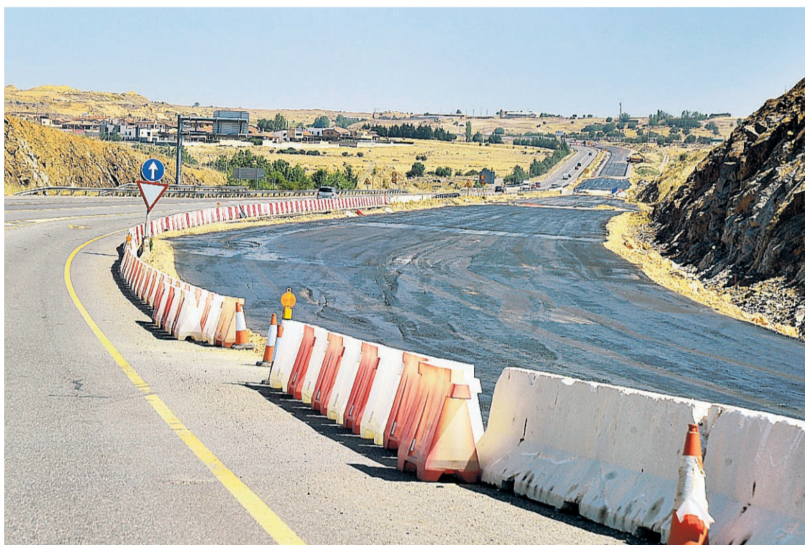
Las obras de desdoblamiento de la carretera de circunvalación SG-20 comenzaron en mayo de 2016.
