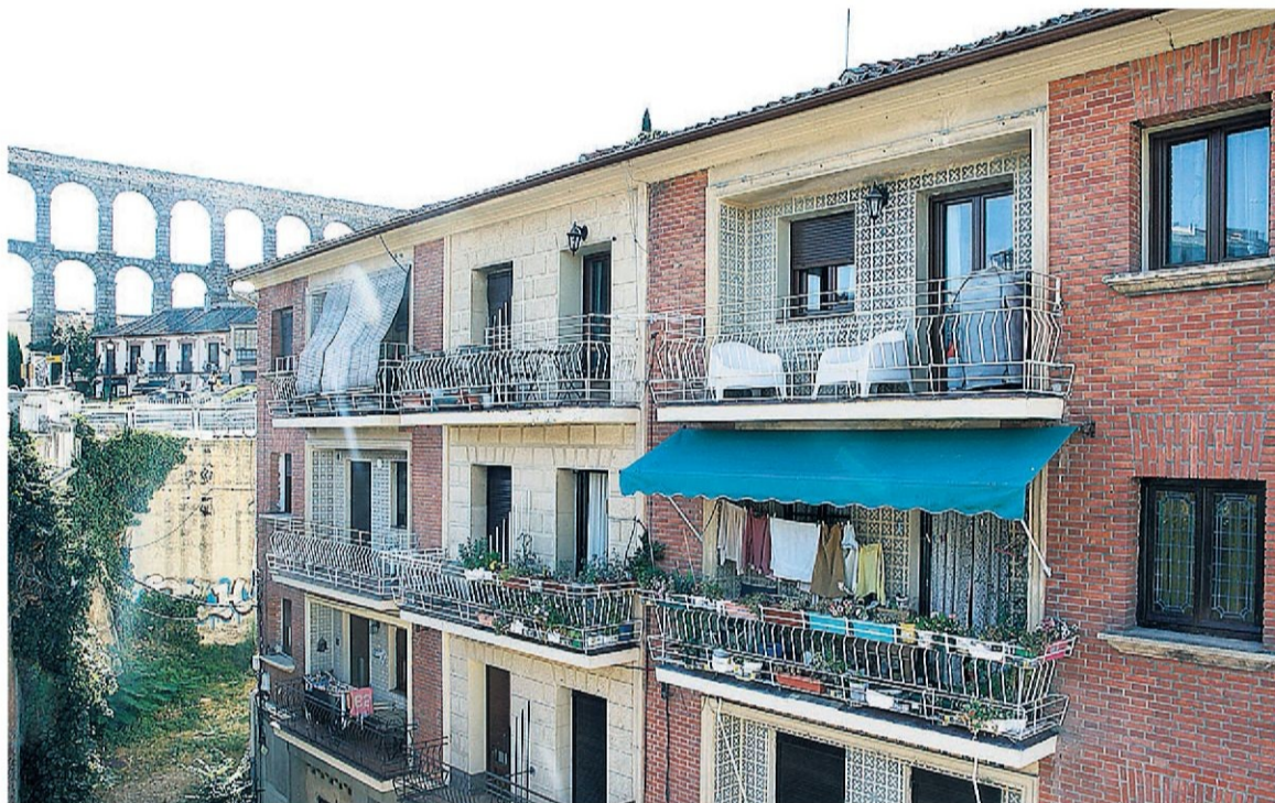
El PEAHIS contempla la demolición de este edificio de viviendas de la calle de Gascos.
