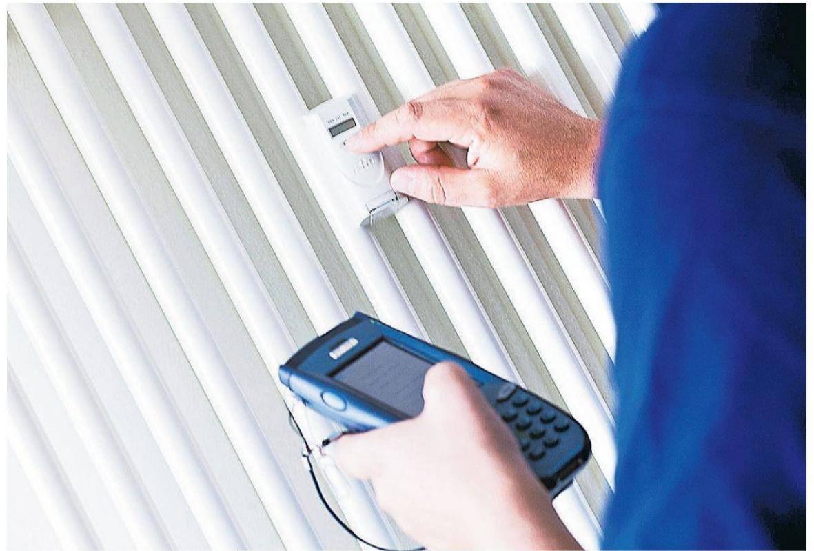
Sistema de medición de consumo energético en una instalación empresarial.
