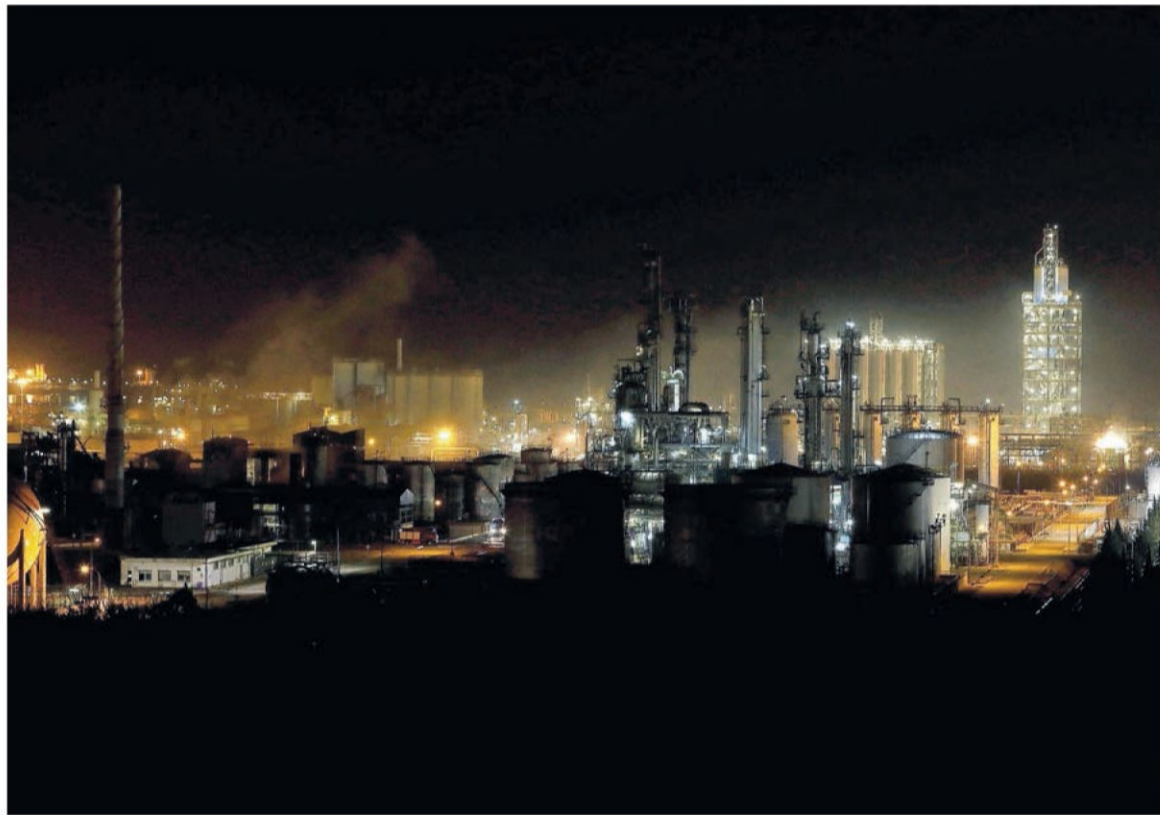
La planta siniestrada en el polígono sur de Tarragona, en el término municipal de La Canonja.
