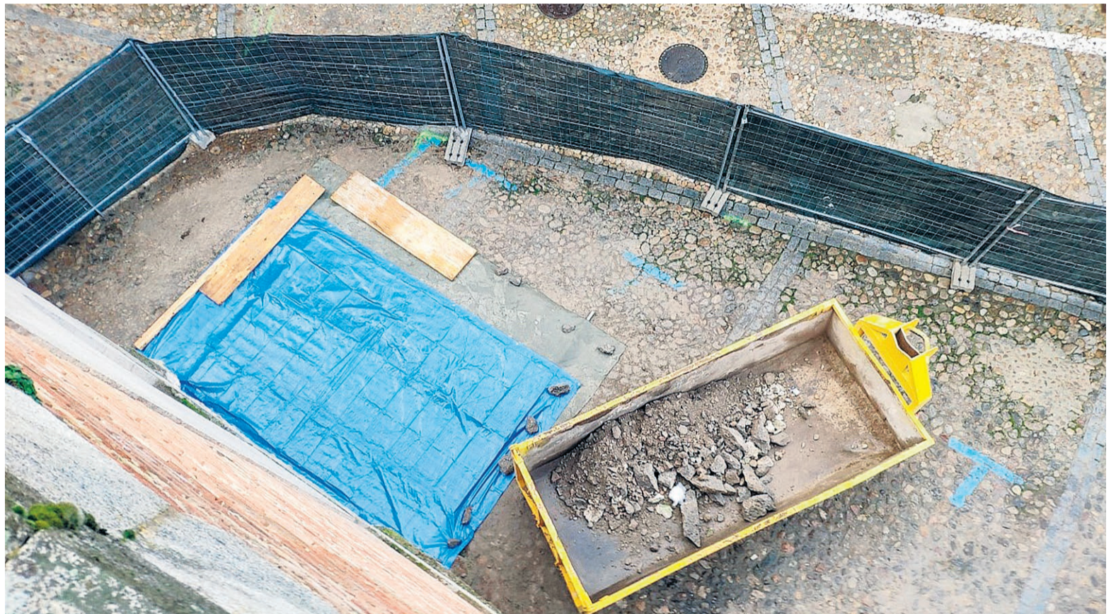
Así se encontraba la ejecución de este ascensor hace ahora un mes, el 2 de diciembre de 2019.
