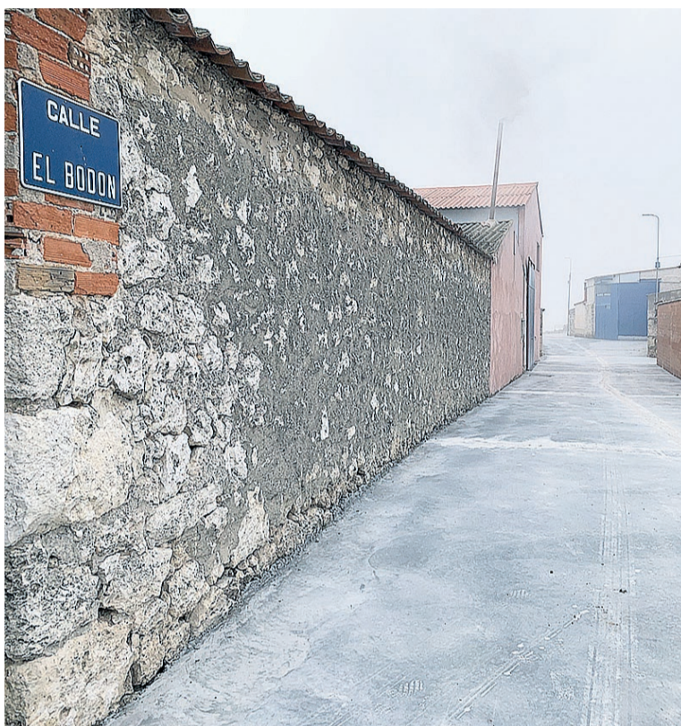
Calle El Bodón, pavimentada recientemente en Escarabajosa.
