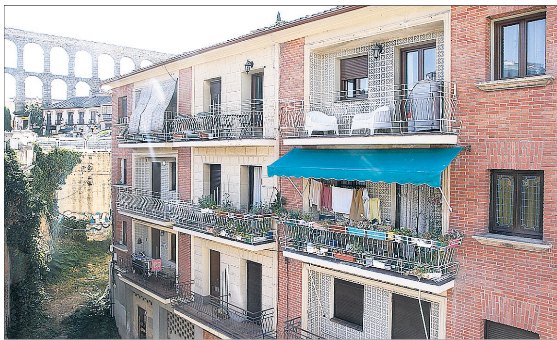
Edificio de viviendas de la calle de Gascos cuya demolición está prevista en el PEAHIS. / NEREA LLORENTE
