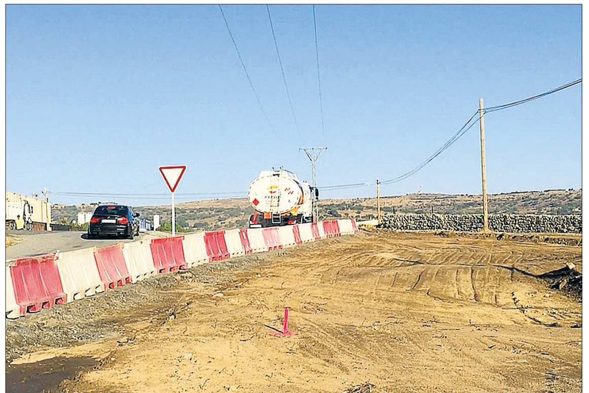
Ya han empezado los movimientos de tierra en la zona donde se va a intervenir. / JOSÉ REDONDO
