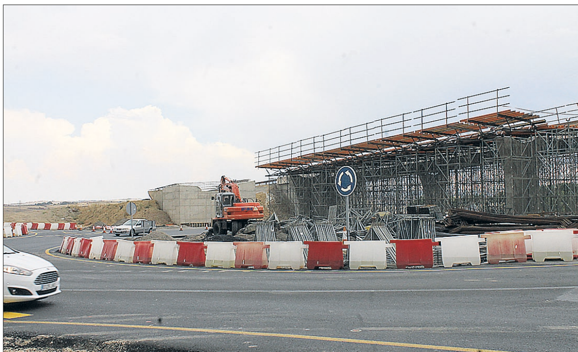
La rotonda y el puente sobre ella comienzan a tomar forma a medida que avanzan las obras. / M.G.
