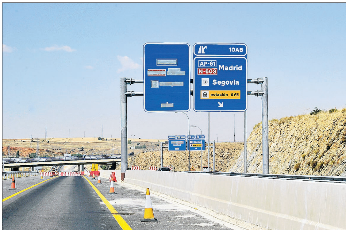
Tramo de la carretera SG-20 en uno de los enlaces con la AP-61 y N-603. / KAMARERO
