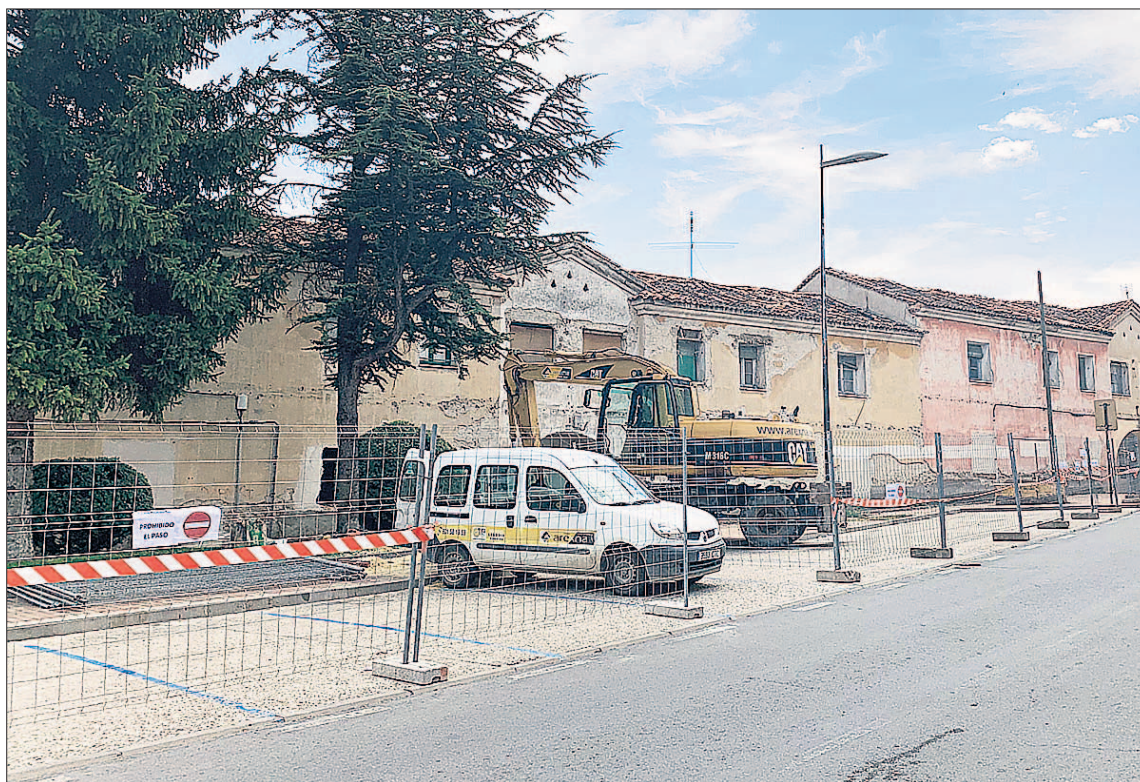
Los trabajos de demolición de las Casas de los Maestros comenzaron ayer./ C. N
