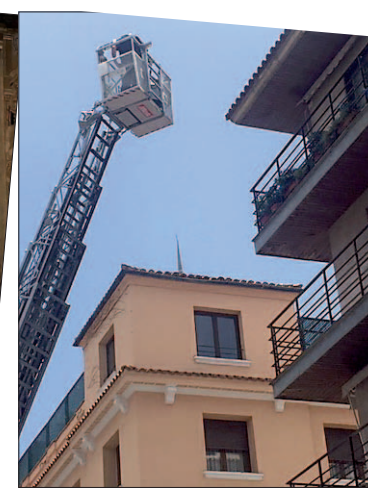
El fuerte viento generó caídas de tejas y persianas lo que propició la intervención de los bomberos.
