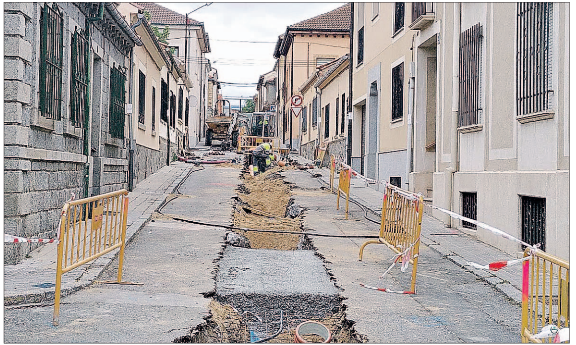
Las obras han alcanzado esta semana a la calle del Ángel del Alcázar de la colonia Pascual Marín. / EL ADELANTADO
