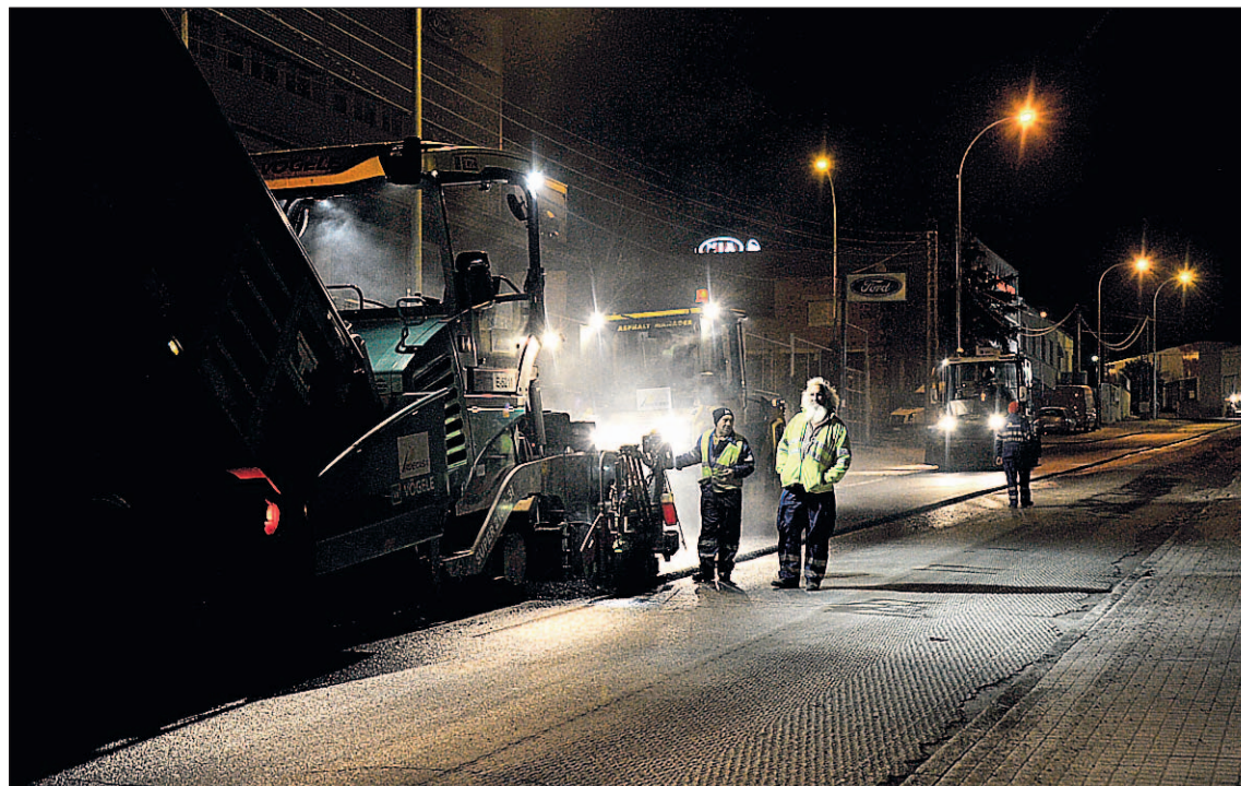
Trabajos de asfaltado realizado durante la noche esta semana en el polígono industrial de El Cerro. / KAMARERO
