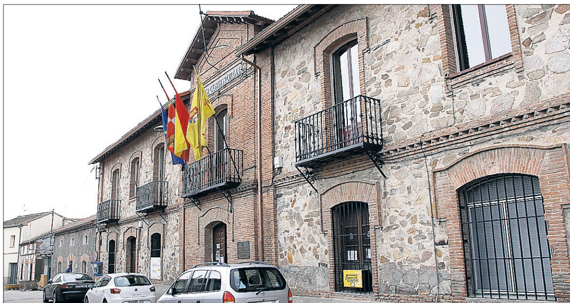
Fachada del Ayuntamiento de la localidad. / NEREA LLORENTE
