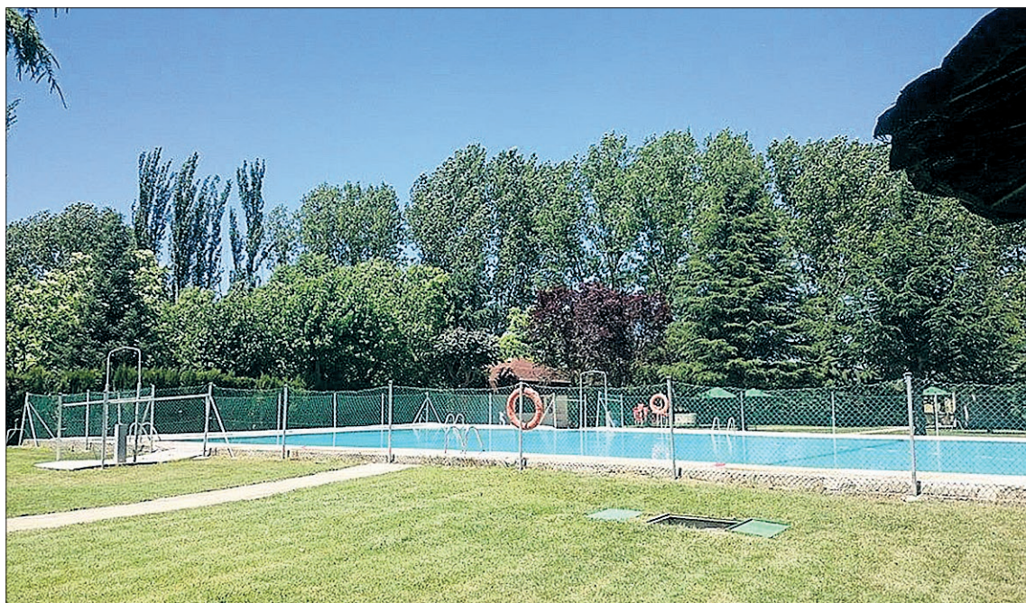
Parte de las instalaciones de la piscina municipal que se encuentran en proceso de licitación. / EL ADELANTADO
