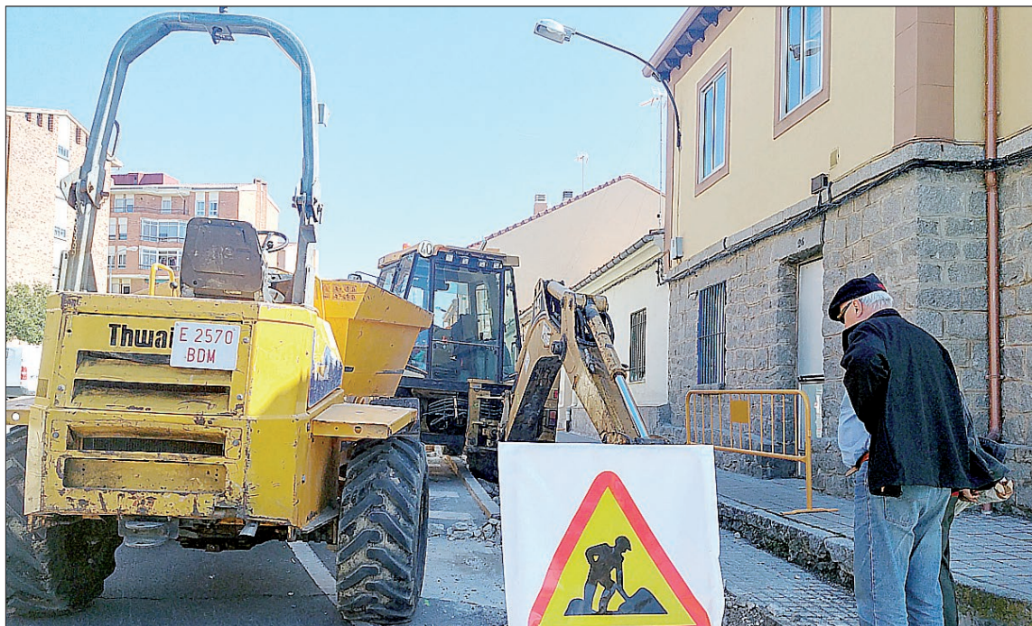
Un vecino contempla la marcha de los trabajos de renovación de la red de abastecimiento en la calle Tejedores. / E. A.
