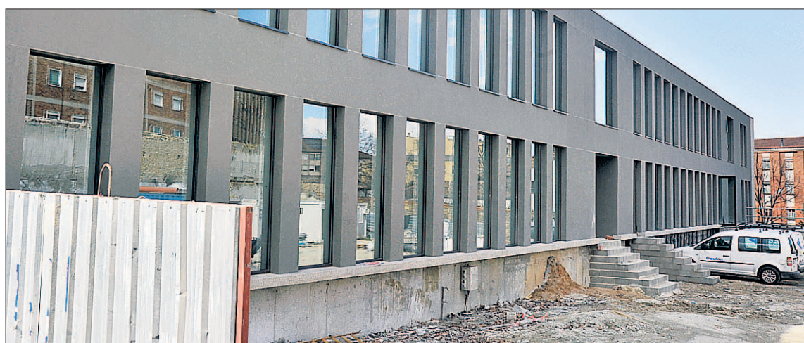
Últimos trabajos en las instalaciones de la segunda fase del campus y su comunicación con el edificio de la primera. /K.
