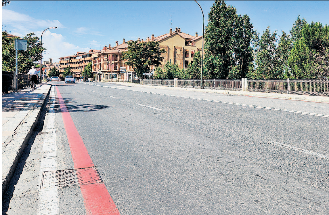
Puente sobre el río Ciguiñuela, en la avenida de Vía Roma del barrio de San Lorenzo. / KAMARERO
