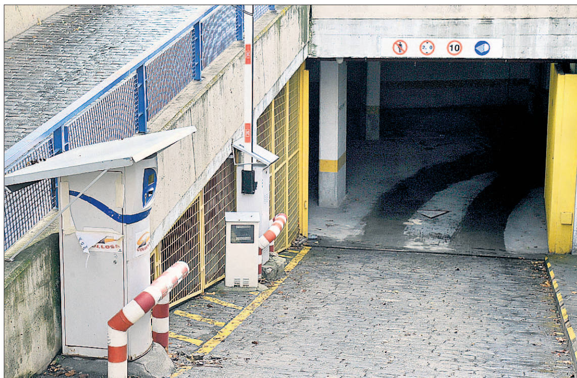
Uno de los accesos del aparcamiento subterráneo de la plaza de José Zorrilla. / KAMARERO
