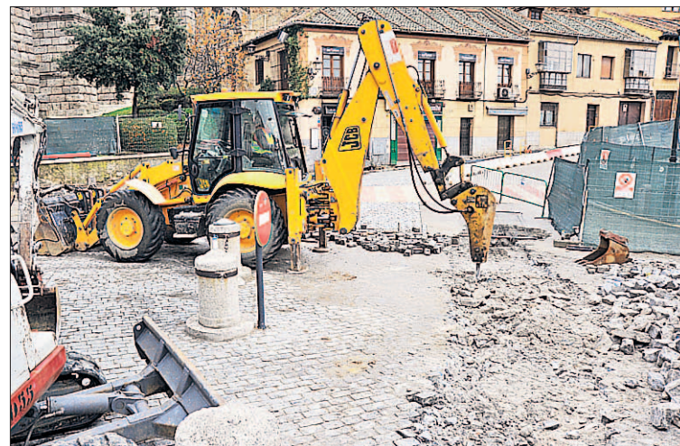
Obras de conexión de la red de abastecimiento en la plaza de la Artillería. / K.
