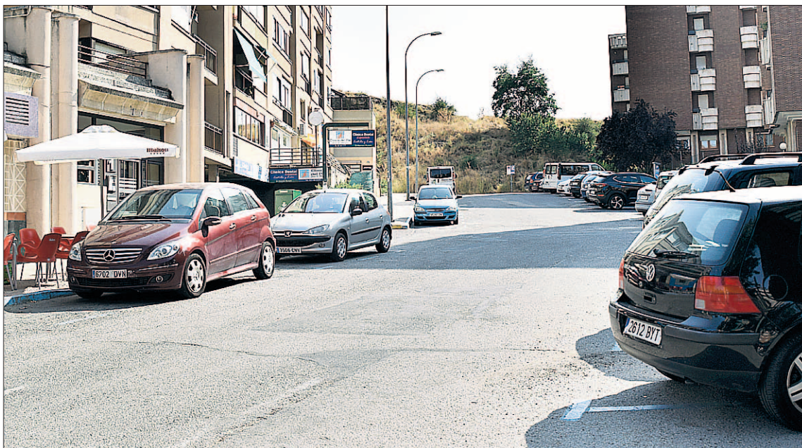
La calle de Los Almendros, en el barrio de Santo Tomás, será una de las vías donde se renovarán redes y se asfaltará. / R. P.
