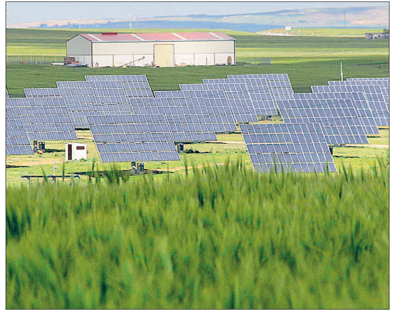
Instalaciones destinadas a captación solar. / EL ADELANTADO
