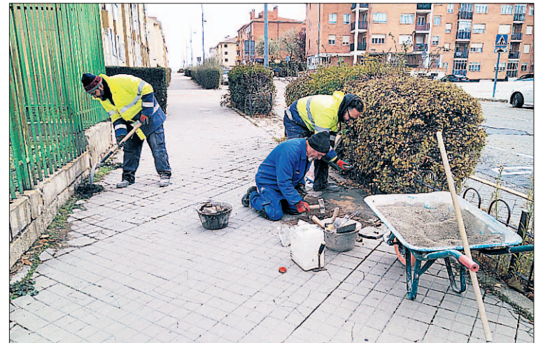
Trabajadores contratados para estas cuadrillas de obras. / E. A.
