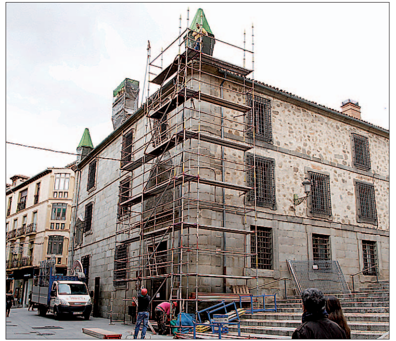
La colocación de andamios en la Casa de la Lectura comenzó ayer. / N. LLORENTE
