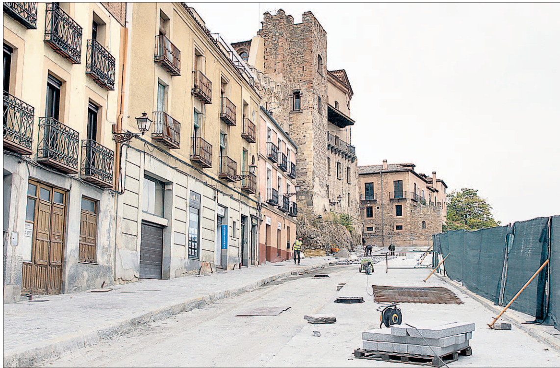
Las obras de urbanización de San Juan continúan sin que se sepa cuándo volverá el tráfico rodado a la cuesta. / N. LLORENTE
