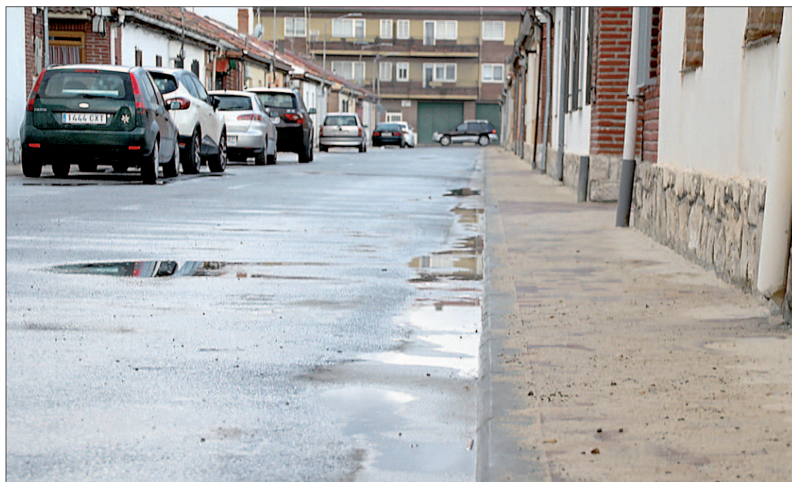
Resultado final de las aceras de cohesión, a tres centímetros de la vía./EL ADELANTADO
