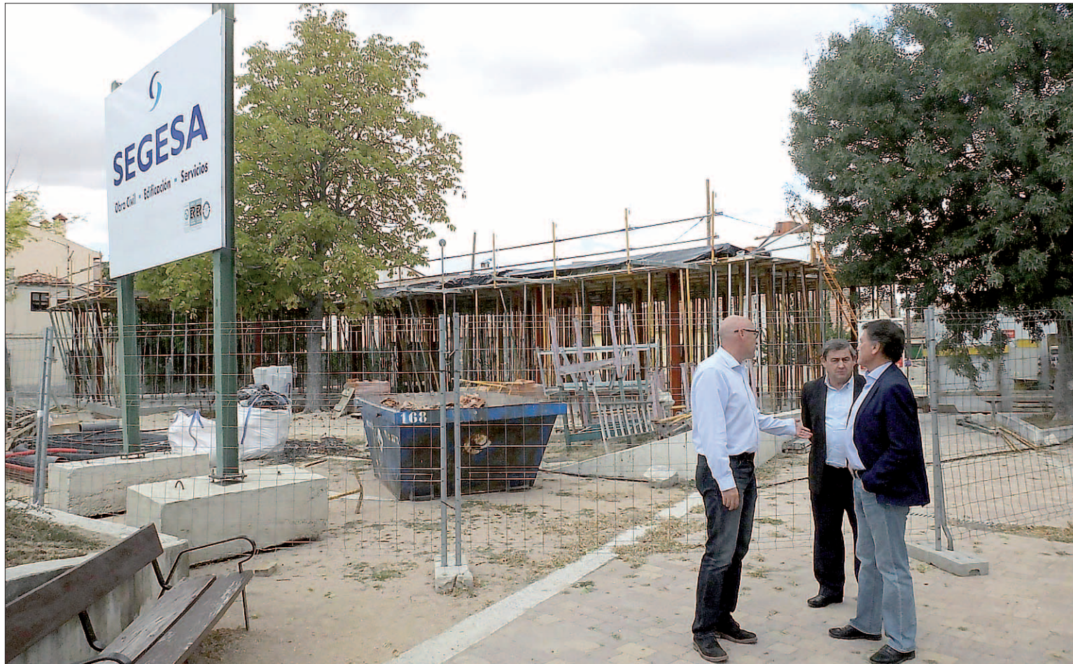
Visita del presidente de la Diputación Provincial, Francisco Vázquez, a las obras del futuro consultorio médico del municipio. / EL ADELANTADO
