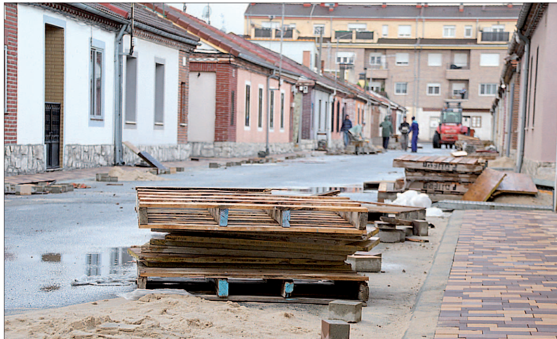
Los trabajos están finalizando en las tres calles, obras realizadas por Mariano Rico S.L./EL ADELANTADO
