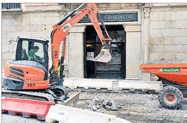
Una excavadora, esta misma semana frente a la sede de la Diputación. / KAMARERO
