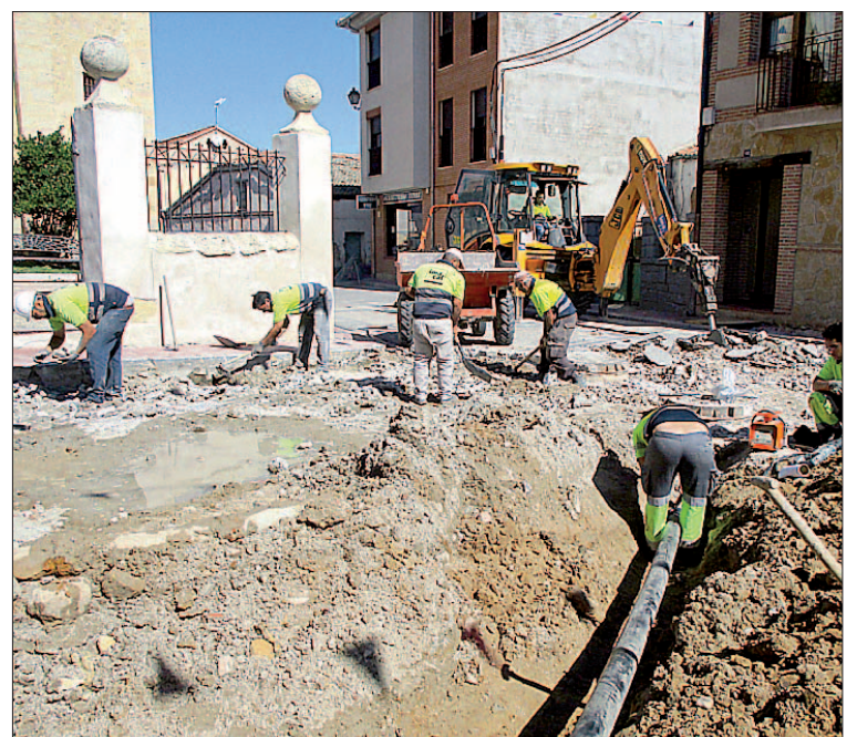
Los obreros están reparando tuberías y sumideros en mal estado. / L. MATARRANZ
