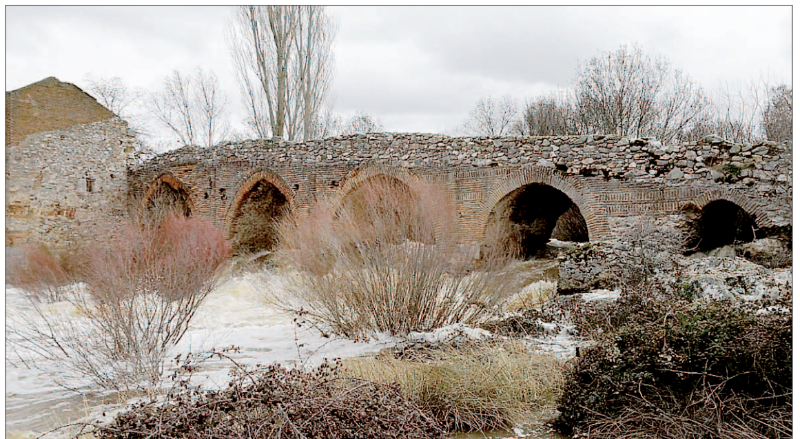
El puente de El Naranjo constituye un paso fundamental para sortear el río Voltoya y comunica núcleos de la zona. / E. A.
