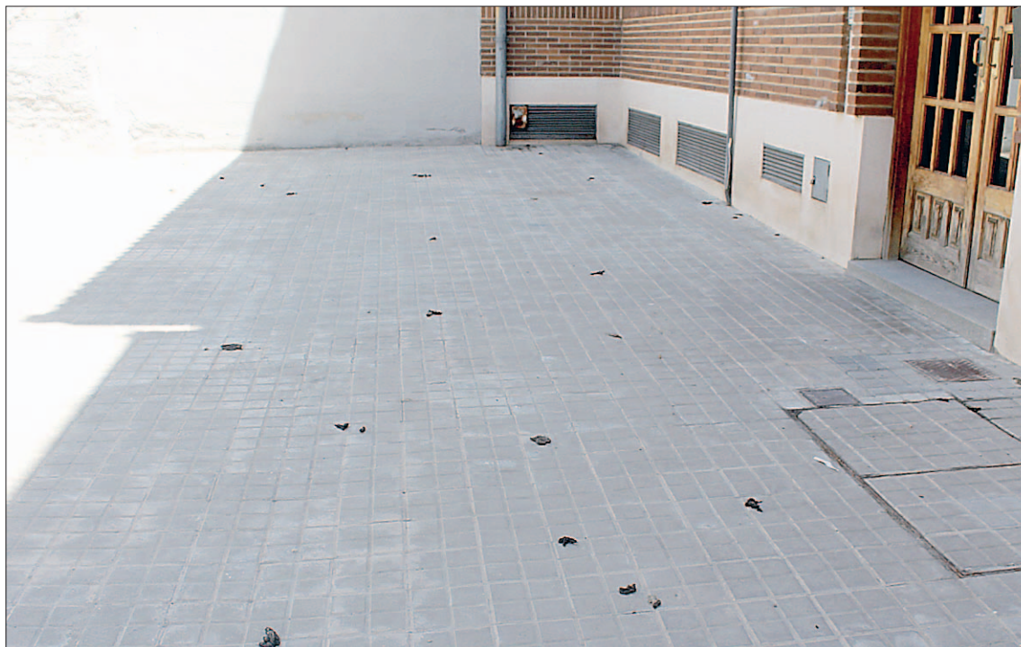
Frente al edificio del número 45 de la calle de La Plata pueden verse numerosas deposiciones de gatos a diario. / M.G.
