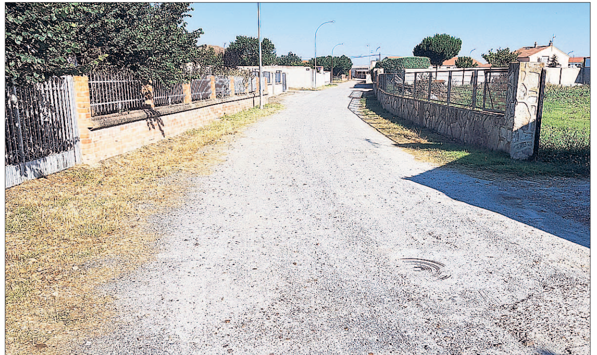
El pavimento actual de la calle Eras está formado por grava, zahorra compactada y, en algunas zonas, tierra vegetal. / E. A.
