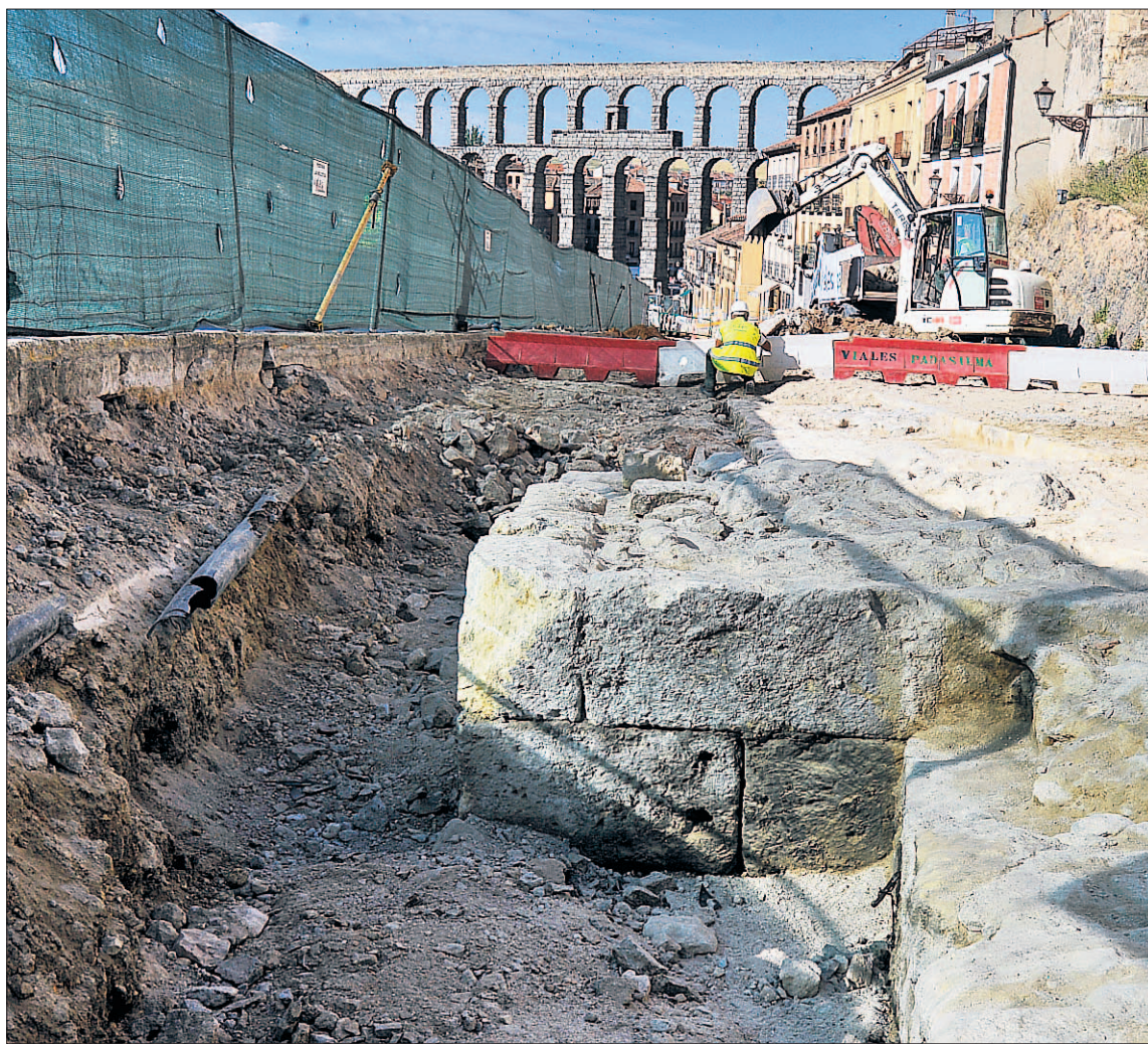
Los trabajos de reurbanización en la calle San Juan han dejado al descubierto un cubo de la Muralla. / KAMARERO
