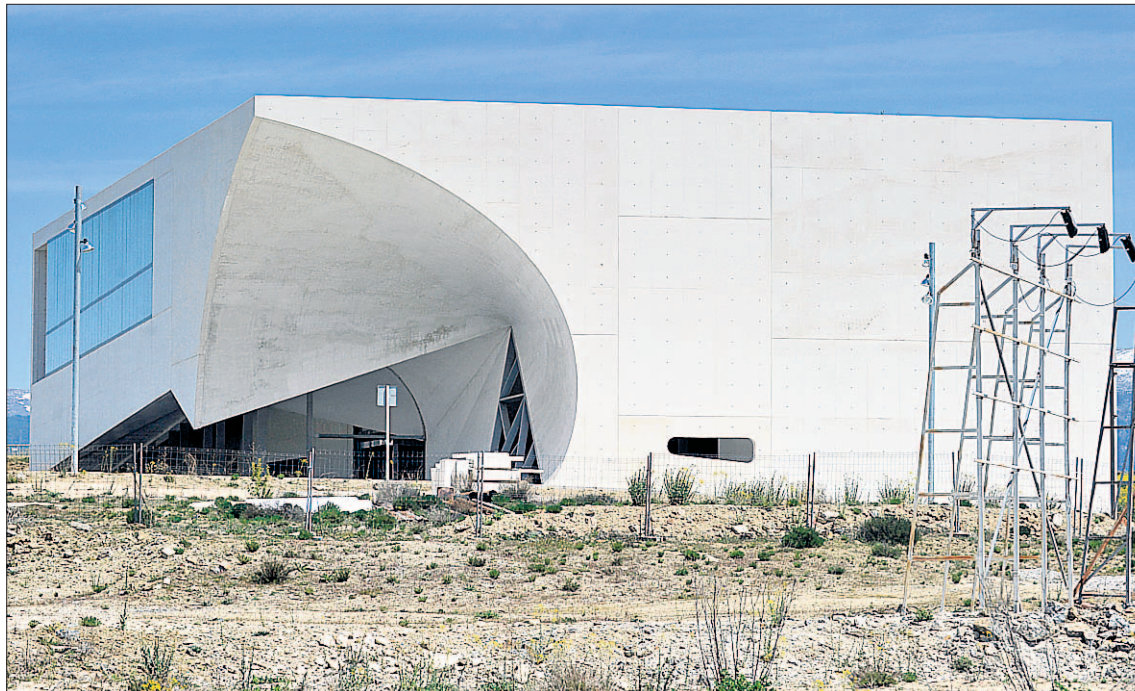
Edificio sin terminar del Círculo de las Artes y la Tecnología (CAT), proyecto muy criticado por el PP. / KAMARERO
