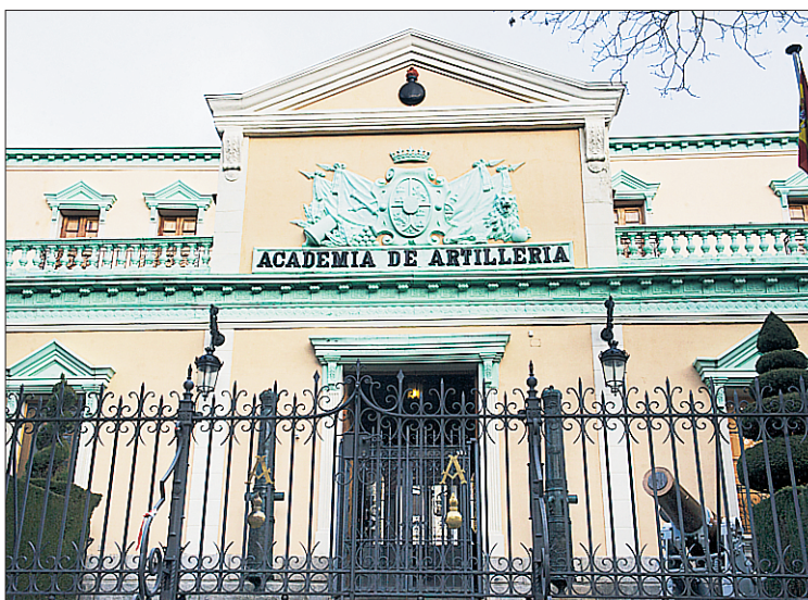
Fachada de la sede de la Academia de Artillería. / KAMARERO
