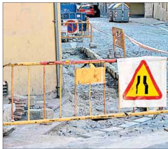
Obras de una acera en la calle San Antón. / KAMARERO
