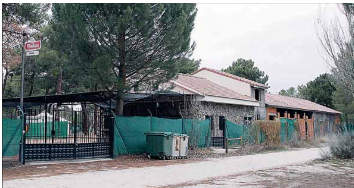
El camping se encuentra prácticamente en estado de abandono desde hace unos dos años. / NEREA LLORENTE
