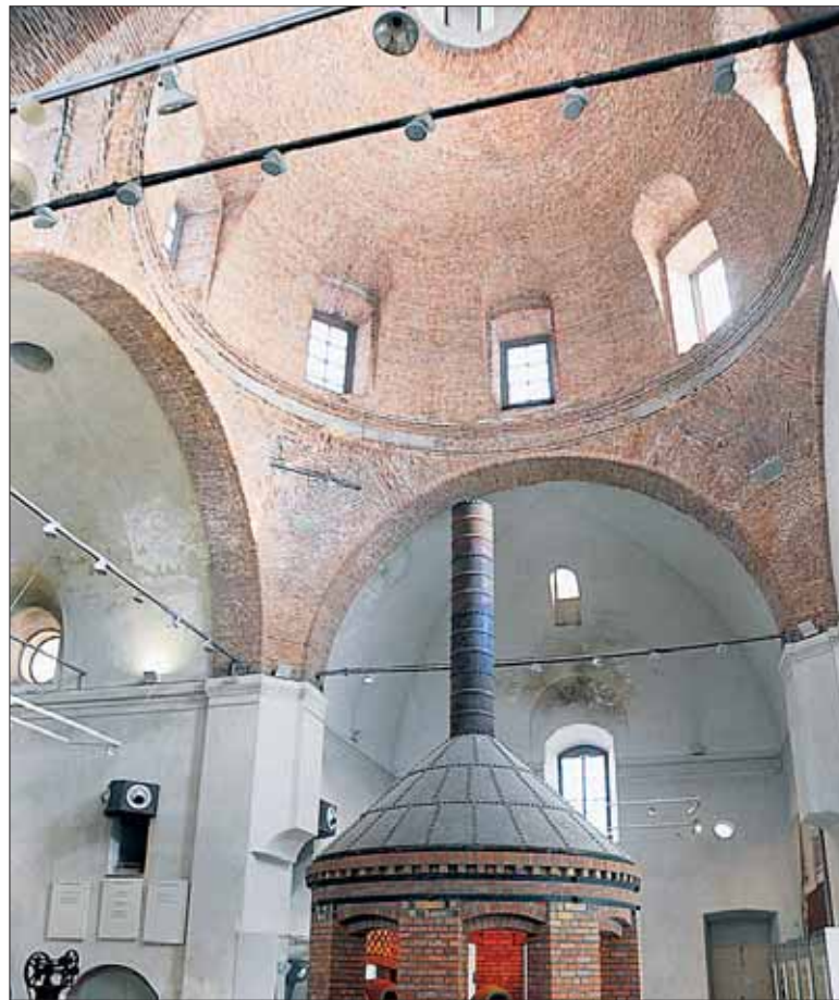
Las cúpulas de la Real Fábrica se construyeron con ladrillos. / KAMARERO
