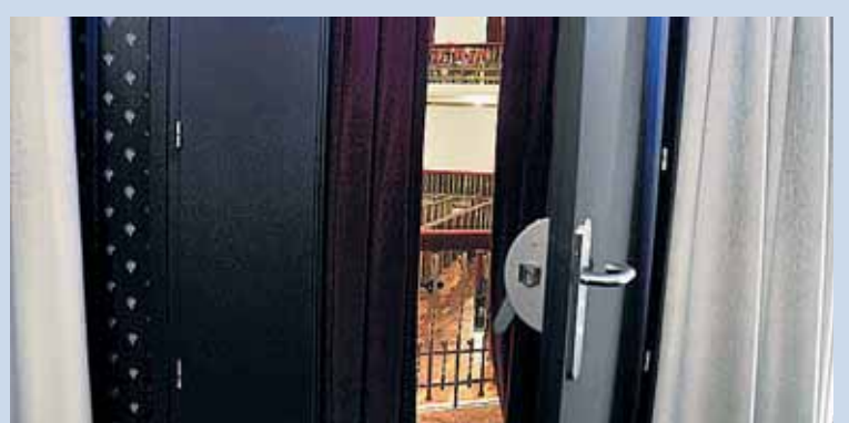
PUERTAS. En el acceso a los palcos de la primera planta se han colocado puertas, con doble cortina, para minimizar los ruidos del exterior.
