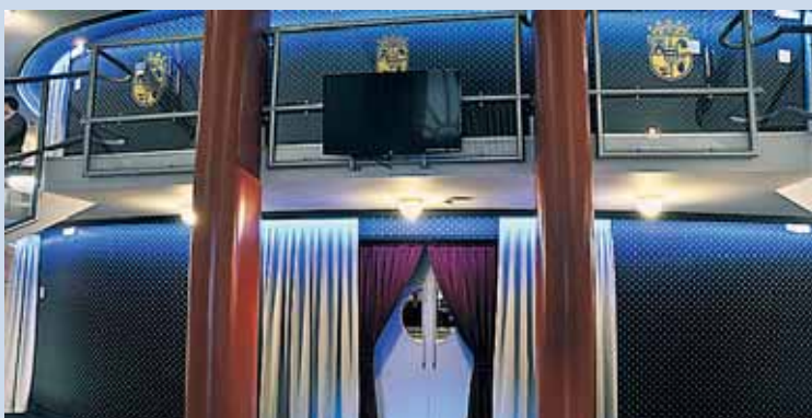
INSONORIZACIÓN. Las paredes se han cubierto con material que absorbe el ruido y se han entelado con una tapicería confeccionada con el logo del teatro.
