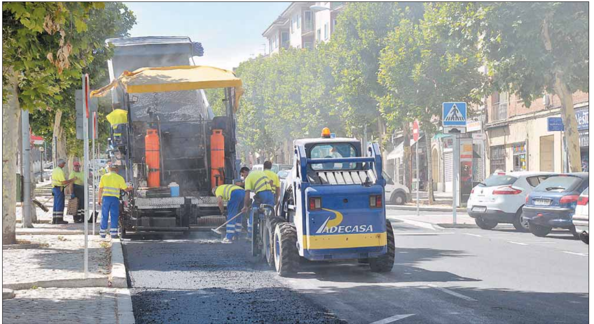
Los problemas surgidos en las obras en la avenida de la Constitución dejaron patente la falta de planificación para acometer un proyecto de gran importancia para la ciudad.
