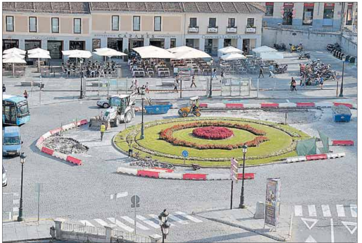
Las obras se han ejecutado a lo largo del mes de octubre y han afectado a varias zonas de la plaza de la Artillería. / KAMARERO
