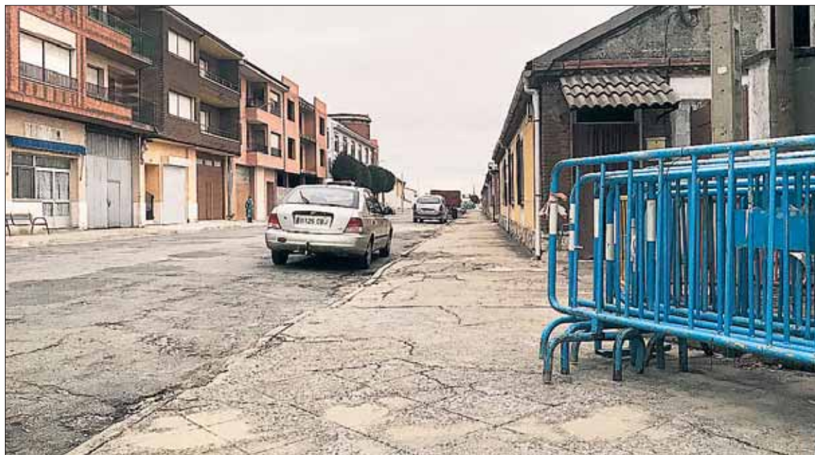
Calle Canteras, cuya acera del margen derecho será acondicionada. / C.N.
