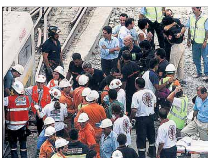
El incendio registrado durante los trabajos del AVE en 2003. / KAMARERO
