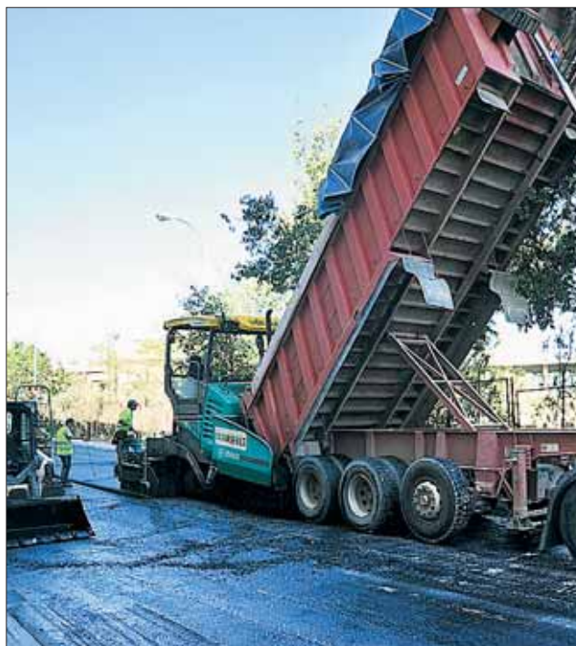
Un camión vierte la mezcla en la carretera de Madrona. / K.
