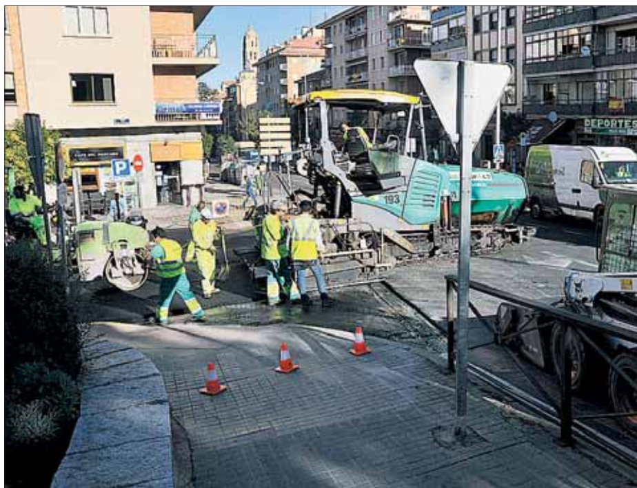
Labores de asfaltado en el acceso a la Estación de Autobuses. / KAMARERO
