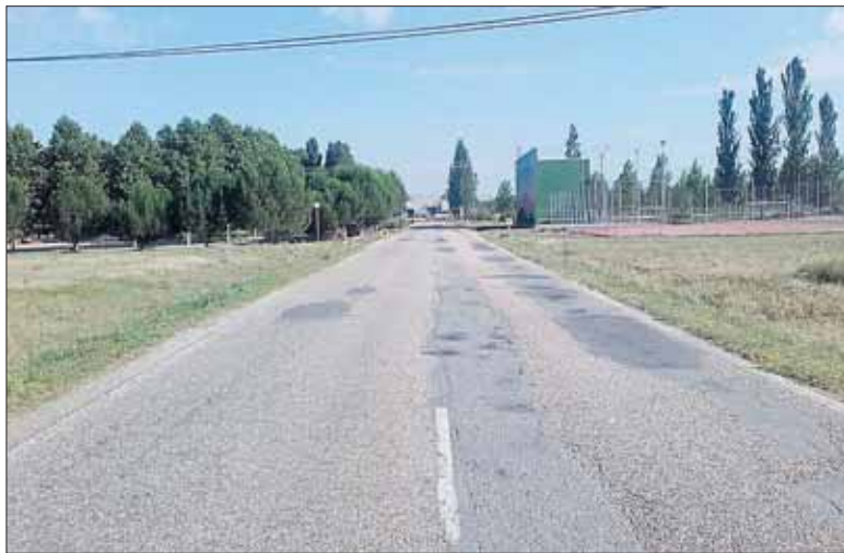
Entrada a Barbolla por la carretera que será acondicionada. / EL ADELANTADO
