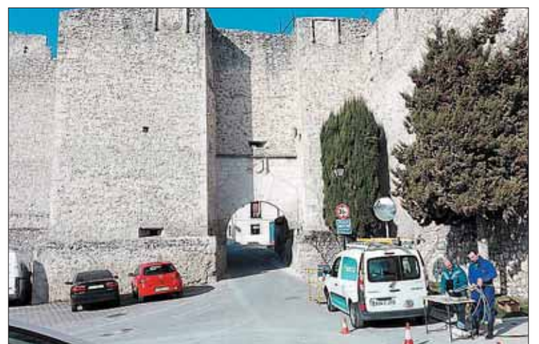
Instaladores de fibra óptica. / CHANTAL NÚÑEZ
