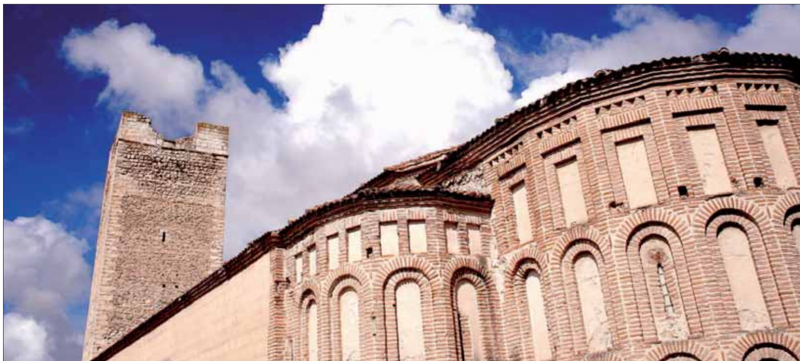
Ábside lateral sur.
