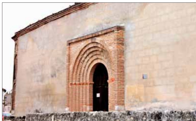
Fachada y puerta norte.
