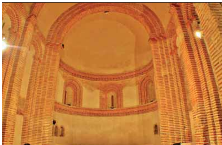
Interior del ábside.
