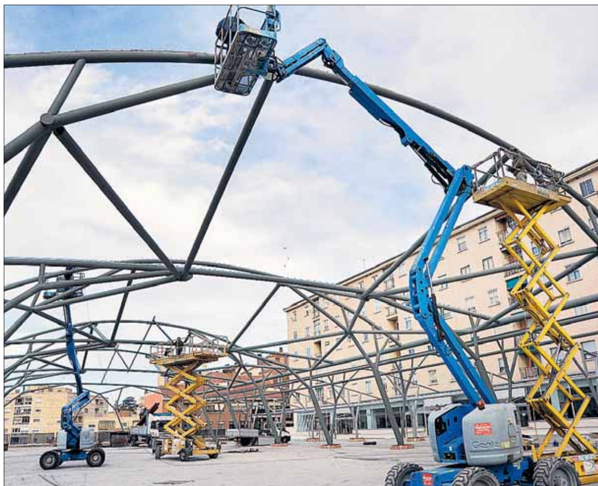
La estructura metálica que sostendrá la cubierta textil tensada se ha pintado de gris en los últimos días. / KAMARERO
