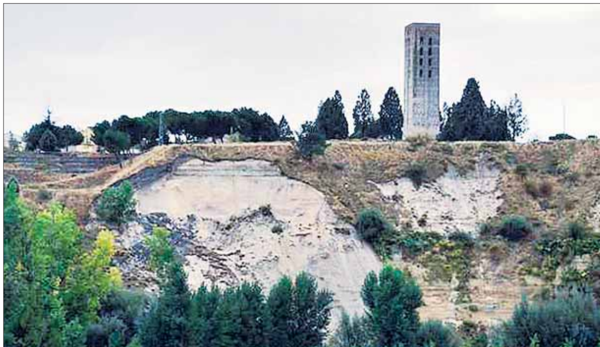
Imagen del archivo de los derrumbes en las laderas del río Eresma. / EL ADELANTADO
