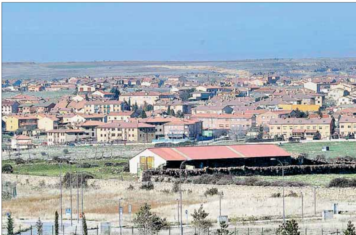
El pleno municipal ha aprobado mejoras de calles en todos los núcleos de Palazuelos. / KAMARERO
