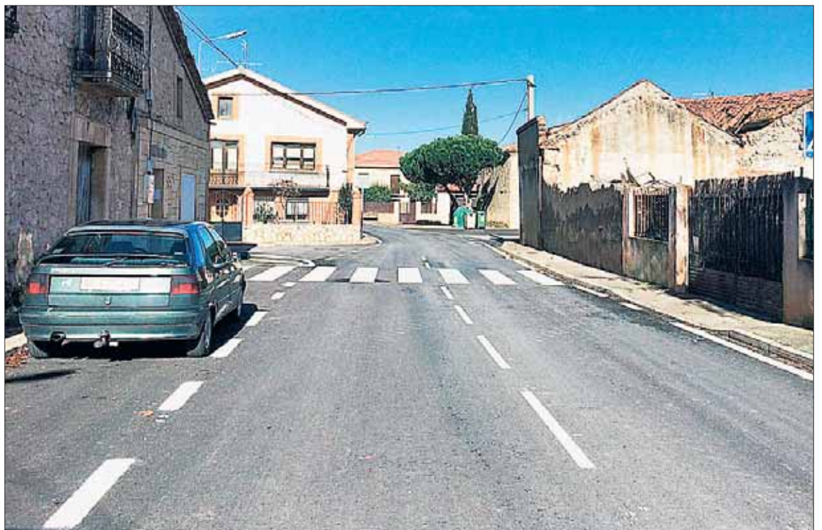
Estado en el que ha quedado la travesía después de las obras. / EL ADELANTADO
