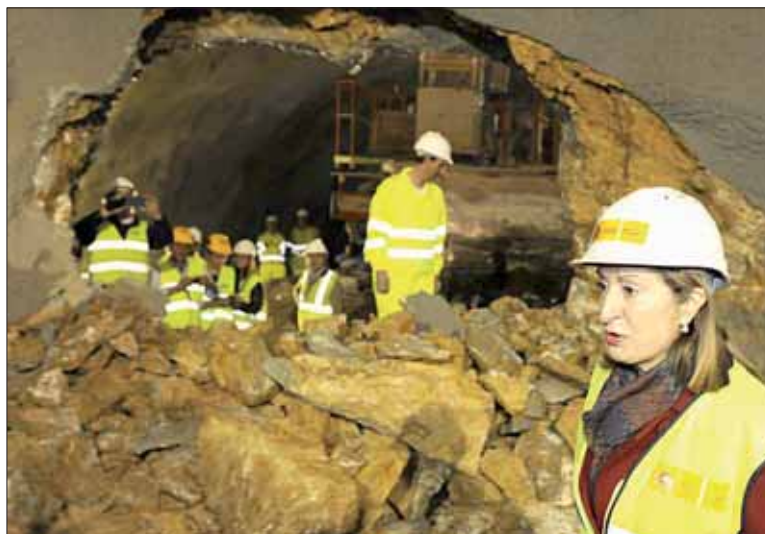
La ministra de Fomento Ana Pastor visita la construcción de una vía férrea. / E.P.
