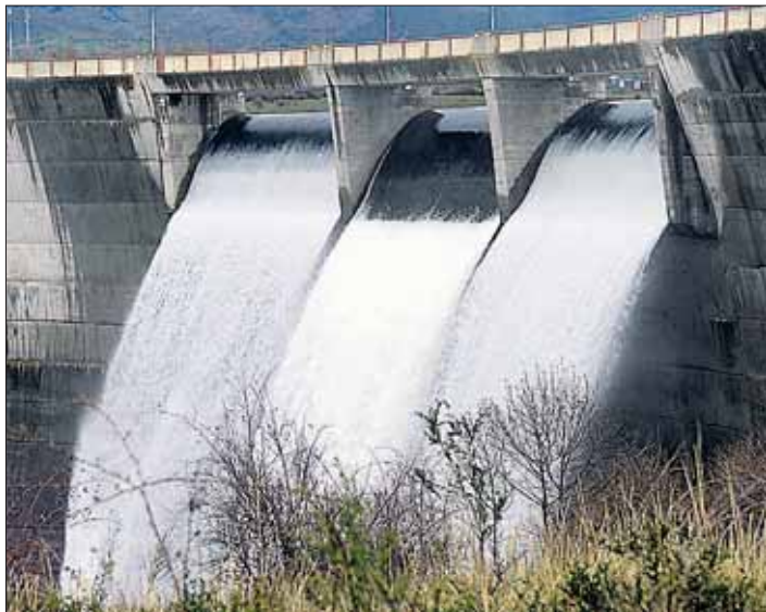
Las compuertas del embalse se abrieron para dejar correr el agua. / KAMARERO
