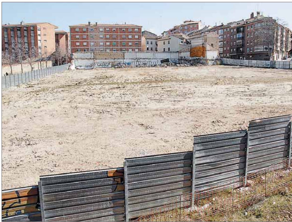
El solar está preparado para el inicio de los trabajos de construcción de la segunda fase del campus público. / JUAN MARTIN
