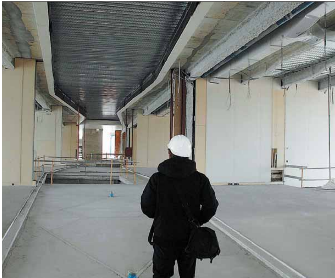
El Ayuntamiento se ha comprometido a retomar en solitario las obras del CAT y finalizarlas el próximo año. // JUAN MARTÍN
