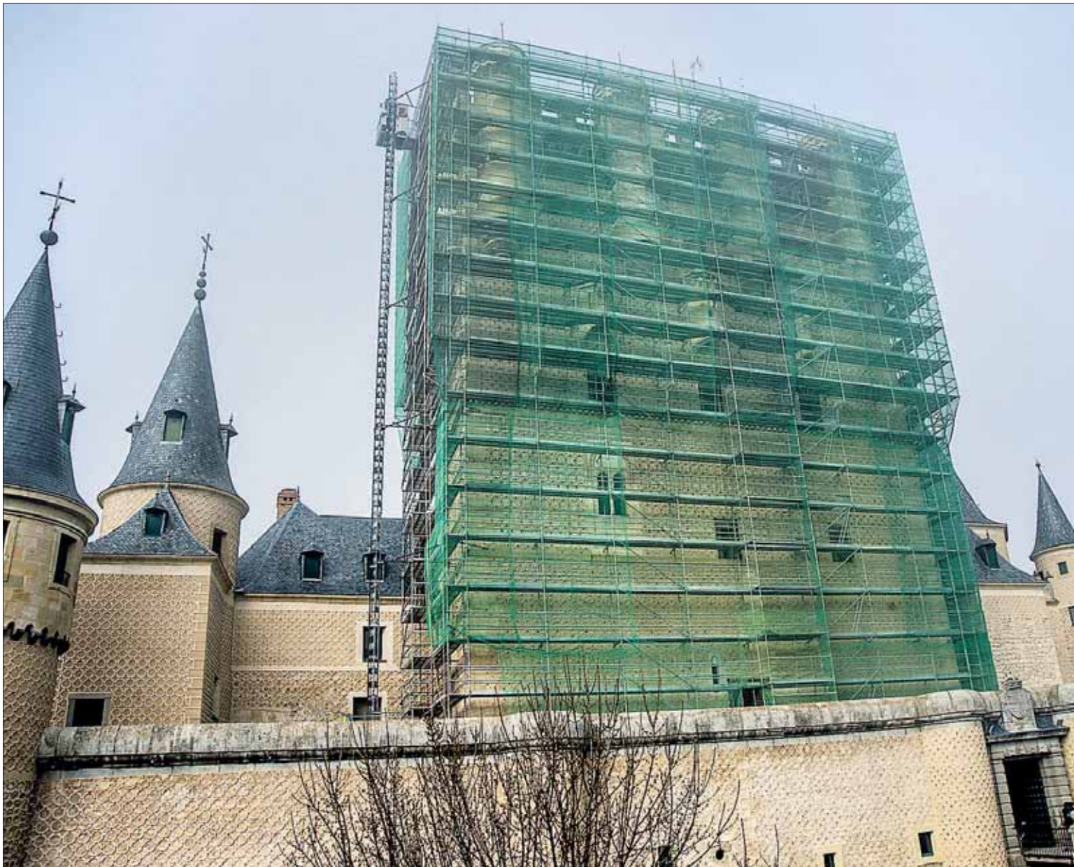
Un gran andamio cubre parte de la Torre de Juan II. La obra permitirá reparar los revocos y sellar grietas detectadas en esta zona del monumento. / KAMARERO
