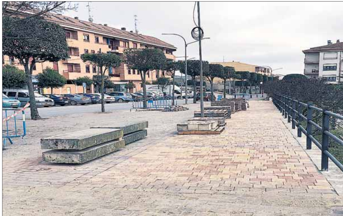
Las obras de mejora de la acera consisten en la eliminación del jardín interno y las irregularidades del terreno. /C.N.
