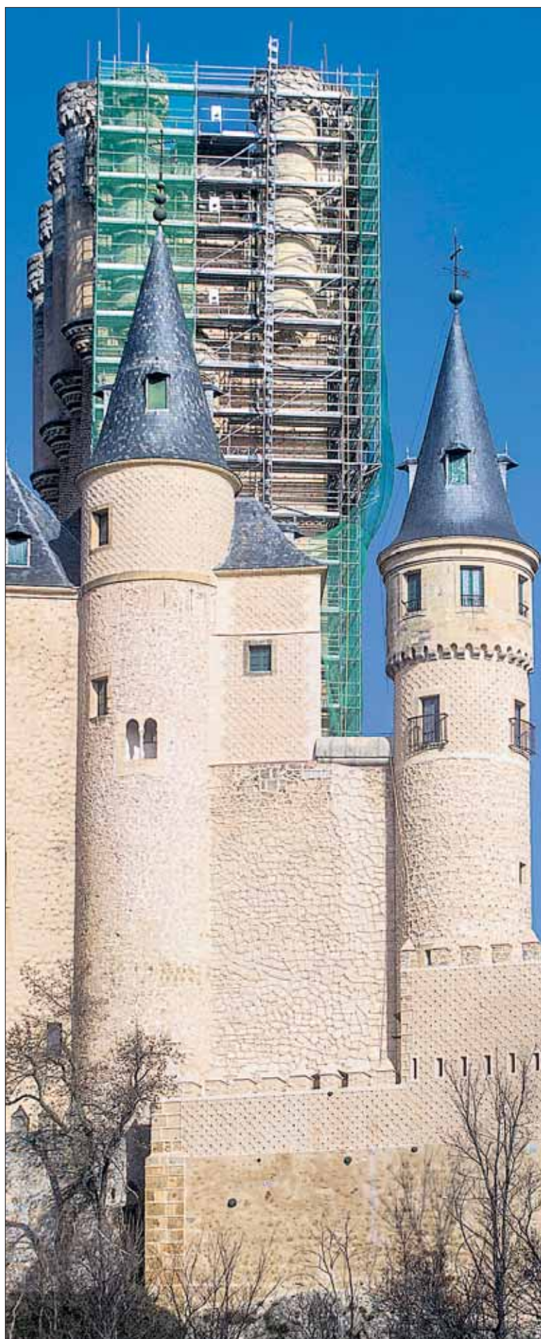
Parte de la Torre de Juan II está hoy cubierta de andamios. / KAMARERO
