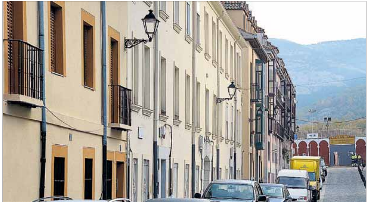
El plazo de ejecución del proyecto de cambio de las luminarias es de dos meses. / KAMARERO
