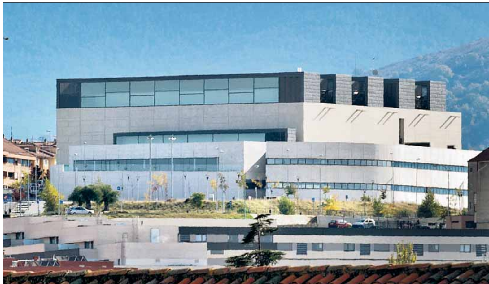
Nueva sede de la Biblioteca Pública del Estado, en el barrio de Comunidad de Ciudad y Tierra de Segovia. La superficie útil se acerca a 8.000 metros. / KAMARERO
