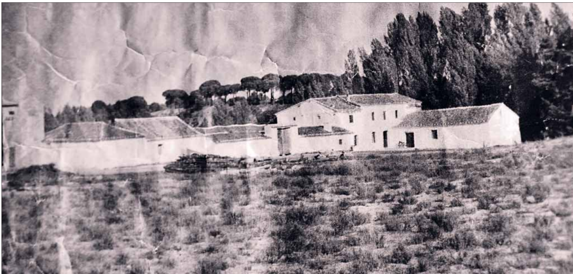
Foto antigua de izquierda a derecha, el transformador de luz, corrales y almacenes, casa, molino y depósito de agua. / JUAN CARLOS LLORENTE
